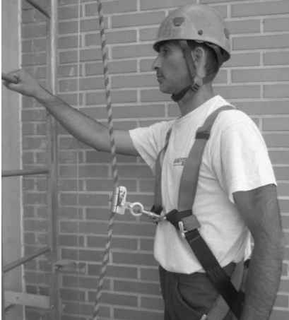
Conexión directa mediante conector separable
